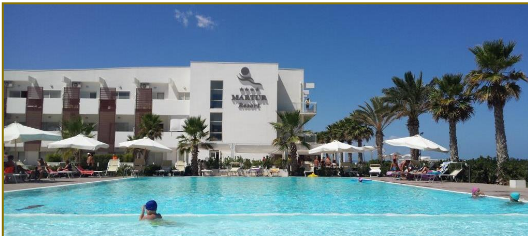
Centro Turistico Residenziale Martur, strutture in c.a. – Termoli (2005)
