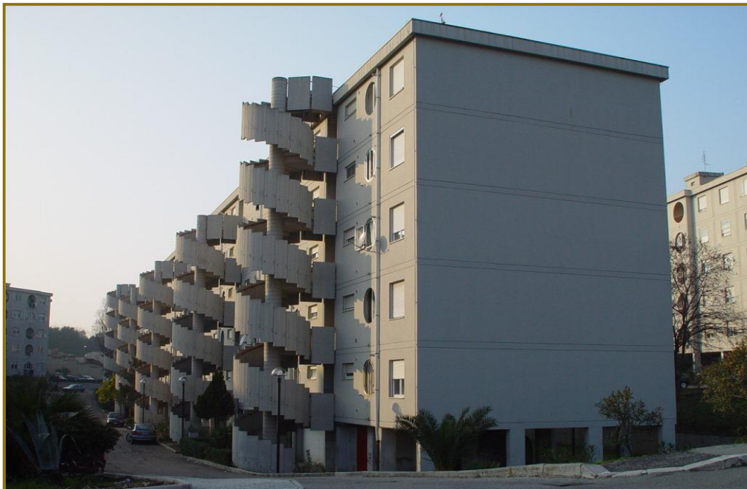
Edilizia sperimentale, via India – Termoli (1980)
