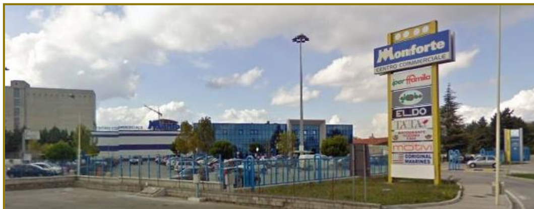
Centro Commerciale Monforte, via Colle delle Api – Campobasso (2004)
