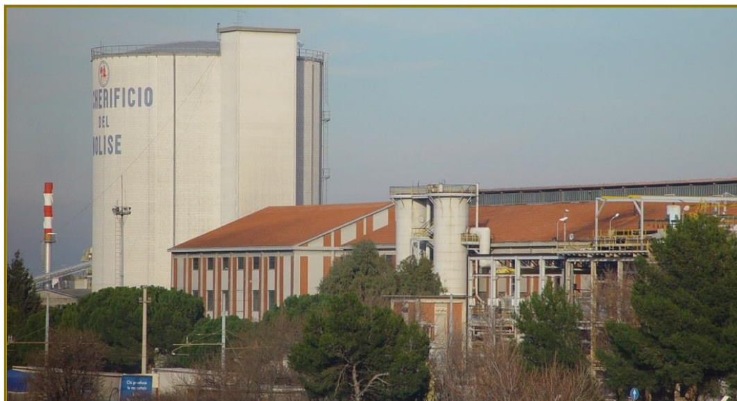
Zuccherificio del Molise, silos - Termoli (1984)
